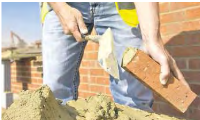
Un operaio al lavoro in un cantiere
