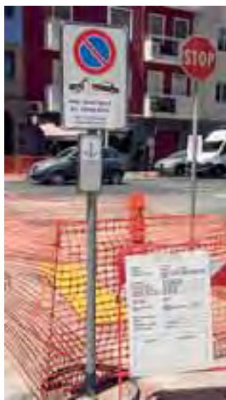
Cantiere per la posa della fibra ottica
